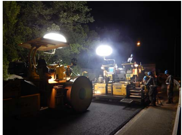
《舗装補修施工状況(イメージ写真)》
