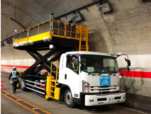
《設備清掃・点検》
