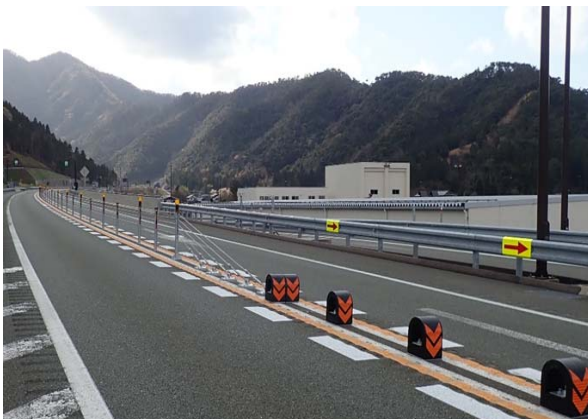
《ワイヤロープ設置工事》
