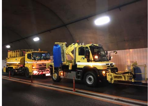
《トンネル側壁清掃》
