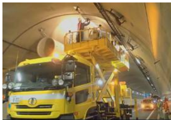
《トンネル設備の清掃・点検》
