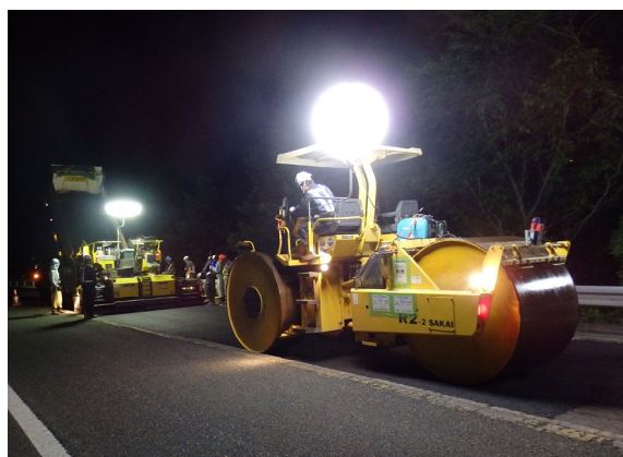
《舗装補修工事》
