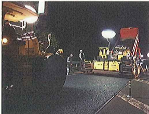
《舗装補修工事》
