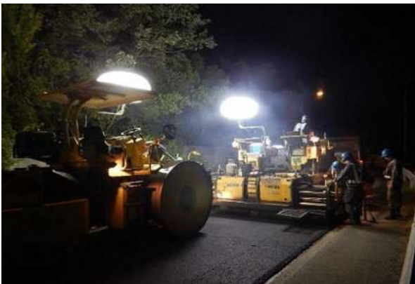
《路面損傷箇所の補修》
