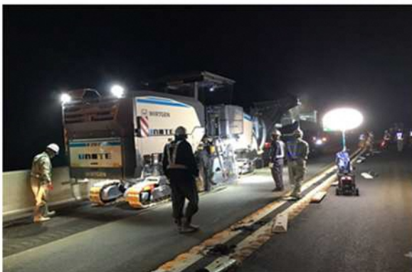
《傷んだ舗装撤去状況》
