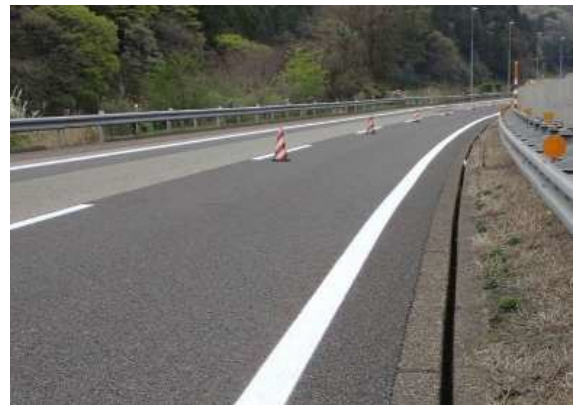
《路面標示工の施工》
