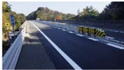
《センターブロック設置の例》
