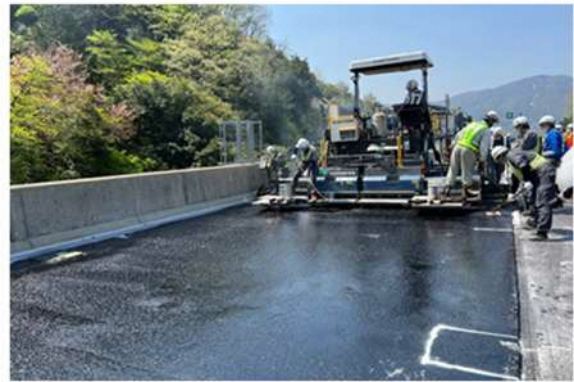
《床版防水工施工状況》
