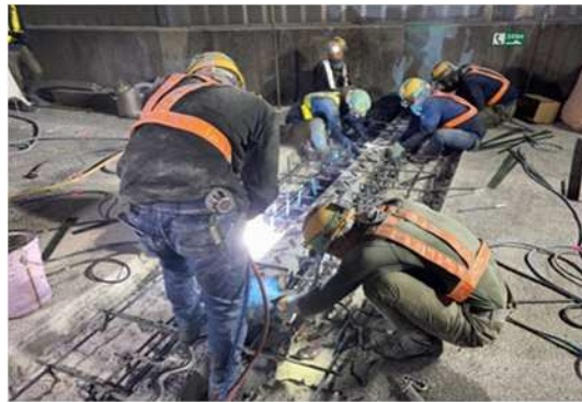
《伸縮装置取替施工状況》
