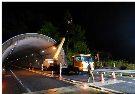
樹木伐採作業
