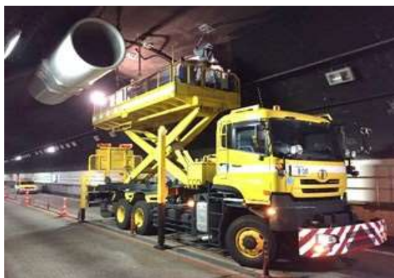
ジェットファン点検作業
