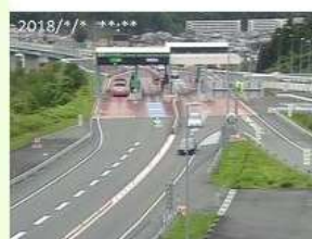
宮津天橋立本線 I C 付近
