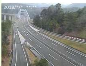
由良川 P A 付近
