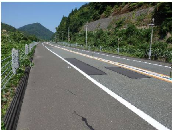
《舗装損傷状況》
