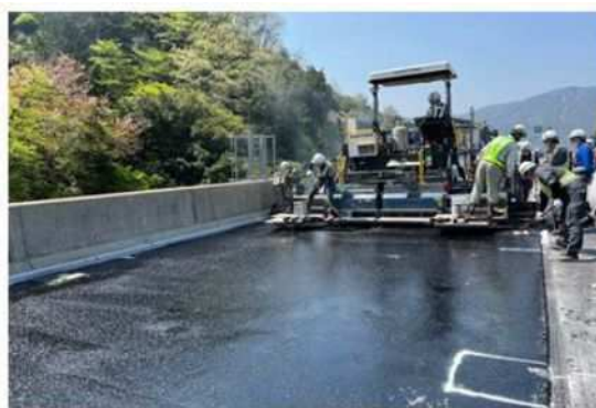
損傷した防水層の再施工状況(イメージ)
