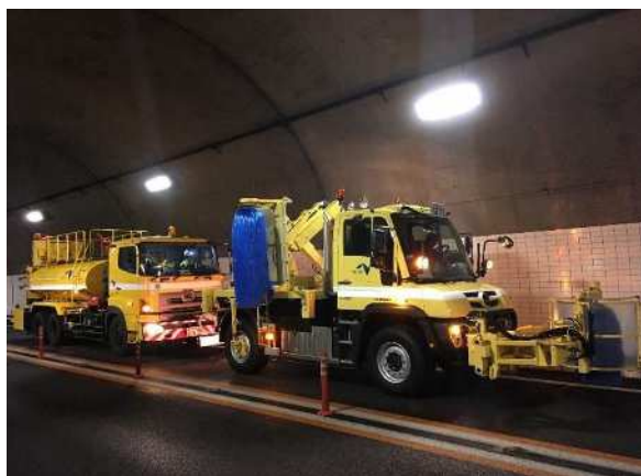
トンネル側壁清掃(イメージ)
