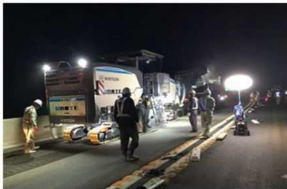
傷んだ舗装撤去状況(イメージ)
