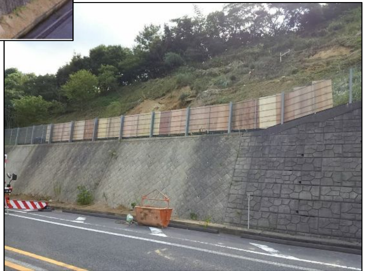
(応急復旧状況)
