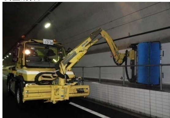
《トンネル側壁清掃》
