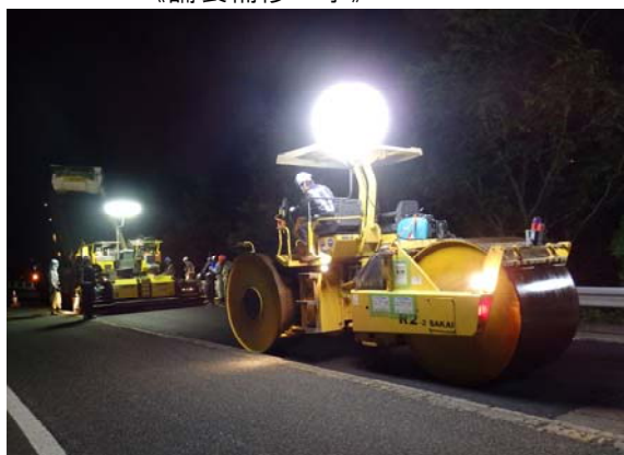
《舗装補修工事》
