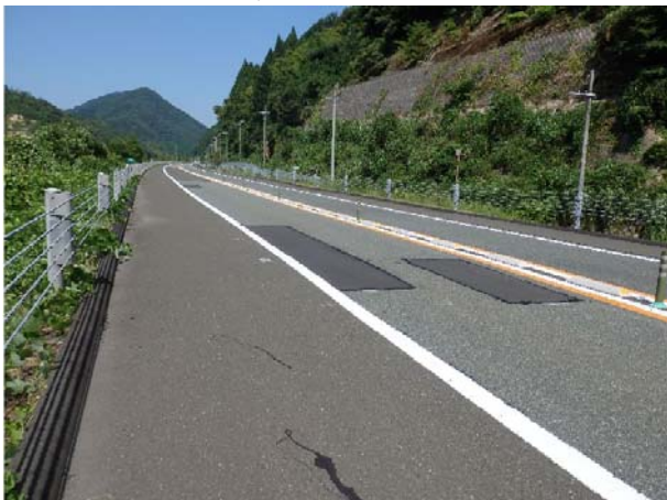
《舗装損傷状況》
