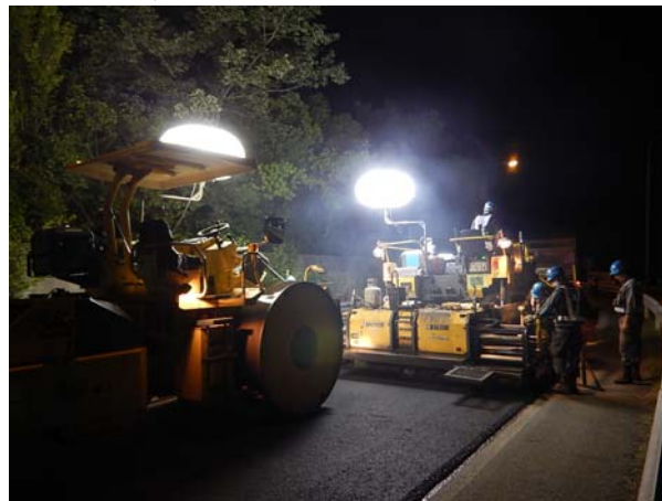
《舗装補修施工状況(イメージ写真)》
