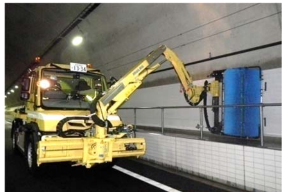
《トンネル側壁清掃》
