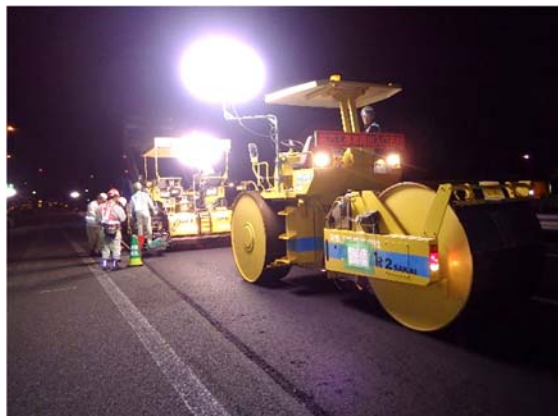
《舗装補修工事》
