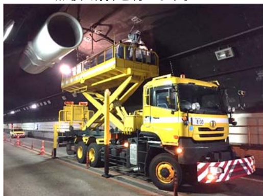
《トンネル設備清掃・点検》
